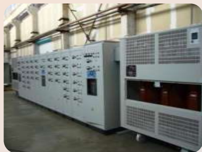
Комплектные трансформаторные и распределительные подстанции (КТП и КРП)
