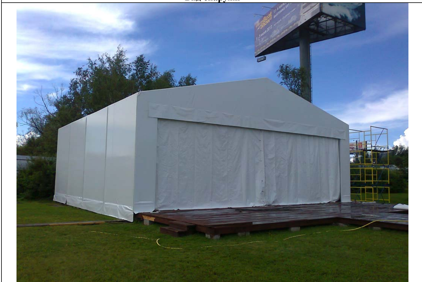
Каркасно-тентовый авиационный ангар размерами 12x12x4,5 (144 м2) для дельтапланов. Место строительства М.О, Дмитровский район, село Старово.
