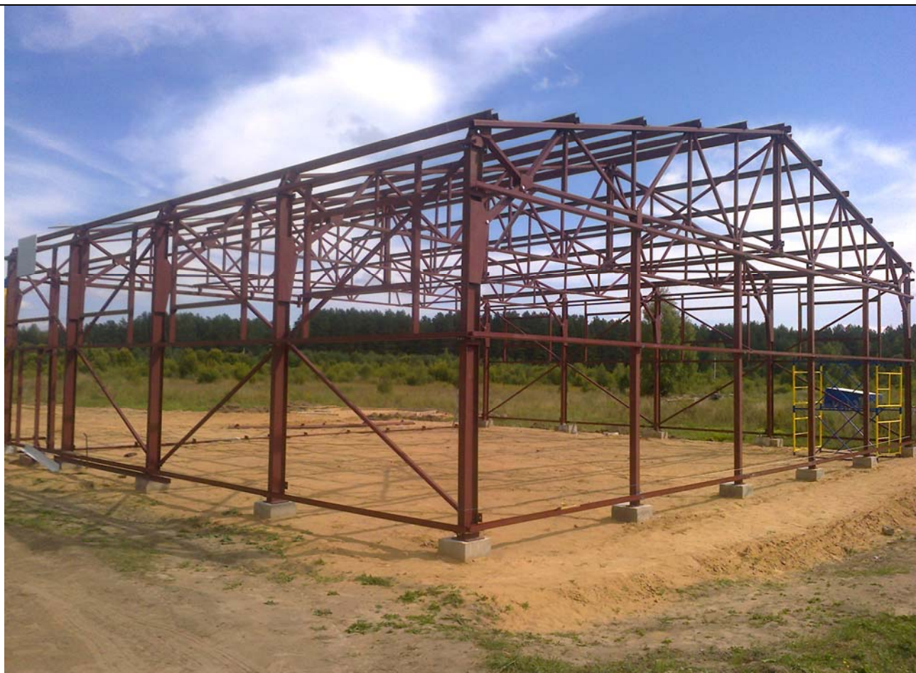
Строительство авиационного ангара размерами 16x14x4,2 (224 м 2 ) из профилированного листа. Место строительства Тверская область, деревня Судниково .
