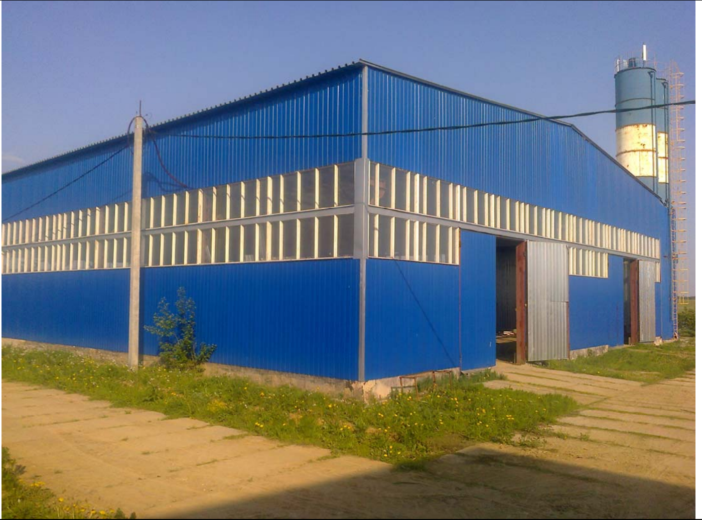
Ангар из сэндвич-панелей толщиной 150 мм., размерами 20х40х8
