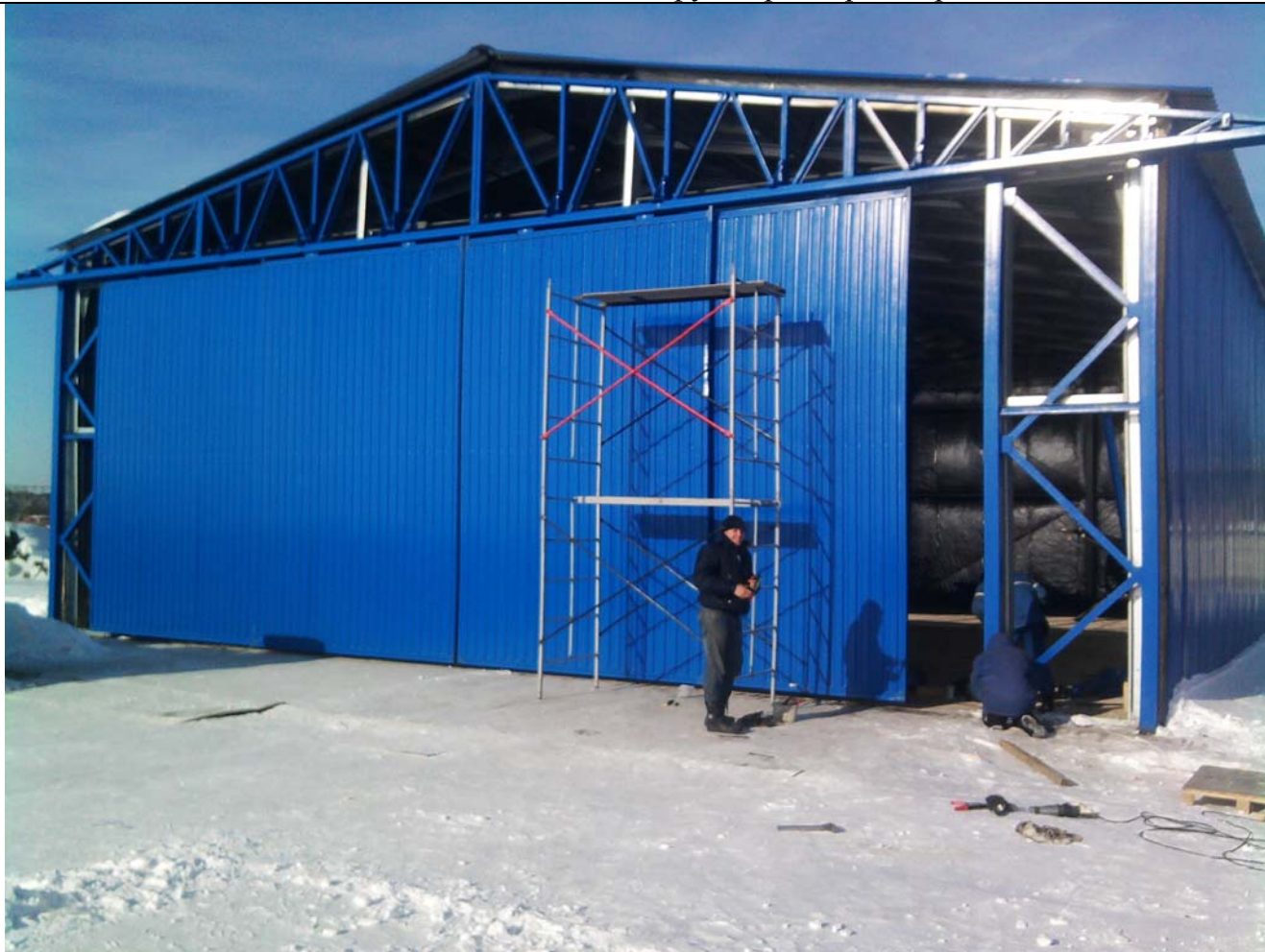
Ангар для гидросамолета Л-42 М из профилированного листа размерами 20x21x5,5 (420 м2).
