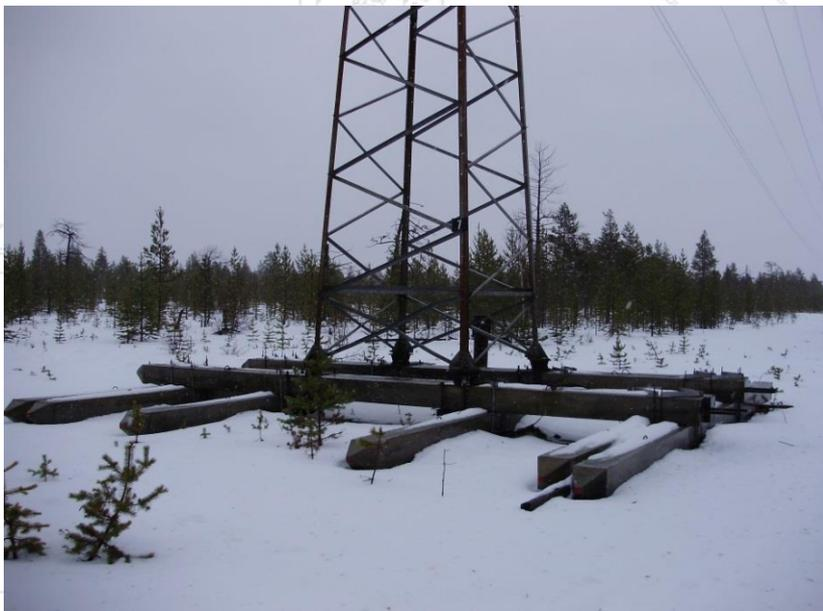
Поверхностные фундаменты применяются на местности с ровным рельефом (без косогоров, склонов и т.п.). Монтаж такого фундамента не требует применения сваебоя и может быть выполнен даже в летнее время, но требует большего количества материалов по сравнению с монтажом типовых фундаментов.
