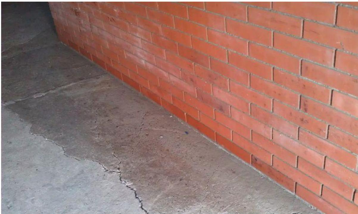
Такая проблема возникает из-за неучтённого при строительстве водоизмещения и из-за расширения грунта под полом.
